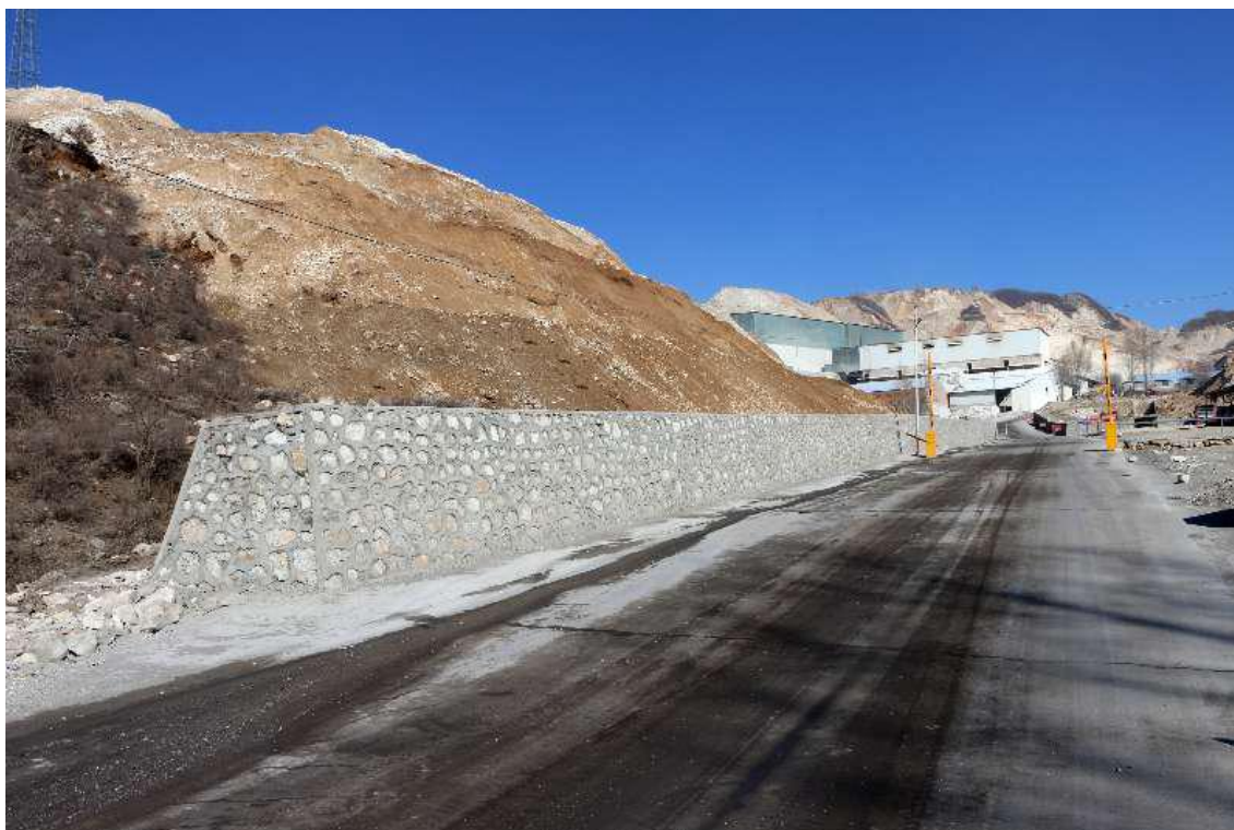
图 3-7 护坡和道路保护基础设施及挡土墙 1
