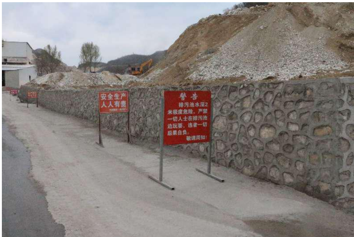
图 3-7 护坡和道路保护基础设施及挡土墙 1
