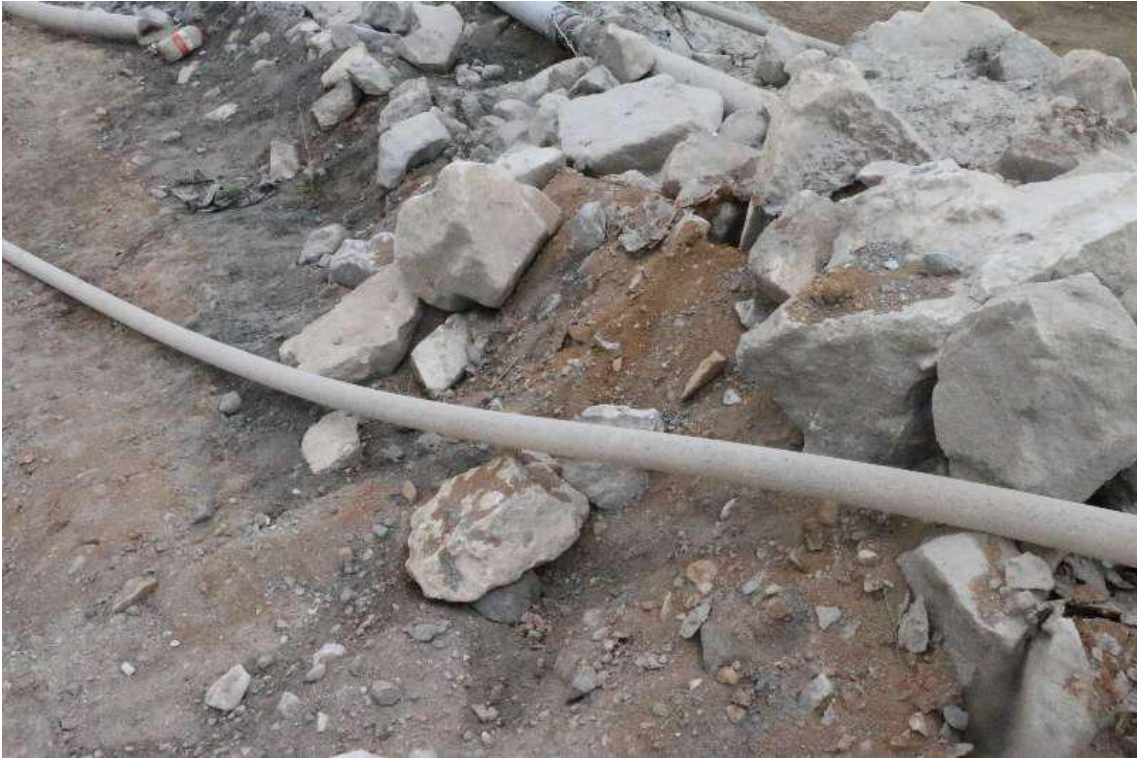
图 3-1 采用软管对各堆场进行洒水抑尘
